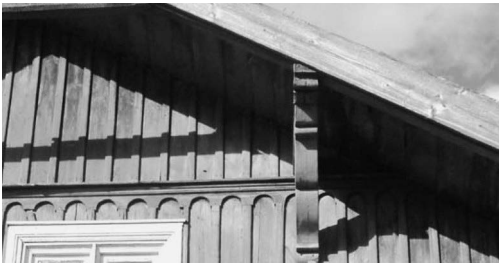
Nr. 78. XX a. pr. medinio namo mansardos apdaila. Profiliuotos stogo atramos. Viešvilė. V. Kucino nuotr. 2012 m.
