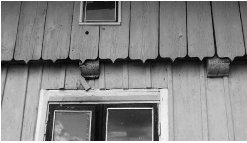
Nr. 76. XX a. pr. medinio namo mansardos apdaila. Profiliuoti sijų ir lentų galai. Viešvilė. V. Kucino nuotr. 2012 m.
