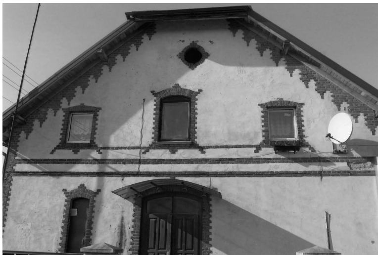
Kapitalinės statybos mūrinio privataus namo išorės tinkuotoje plokštumoje paliktų raudonų plytų dekoru ornamentas
