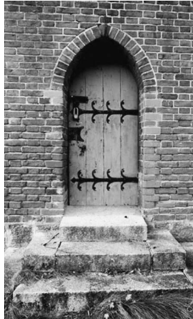
Nr. 87. Bažnyčios durys raudonų plytų sienoje. Žukai. A. Sinkevičiaus nuotr. 2014 m.
