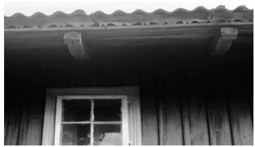
Nr. 77. XX a. pr. medinio namo pastogės apdaila. Profiliuoti gegnių galai. Viešvilė. V. Kucino nuotr. 2012 m.
